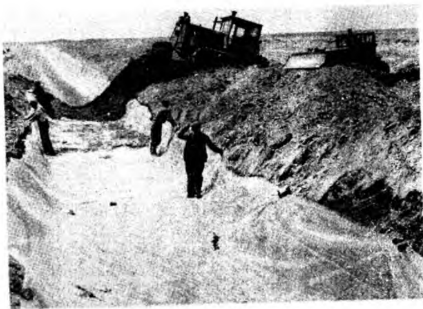
25- расм. Канал тубига полиэтиленли плёнка ётқизиш.
